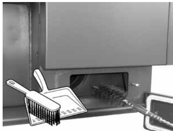
Usuwanie popiołu z dolnej części kanału spalinowego poprzez wieczko dolne
