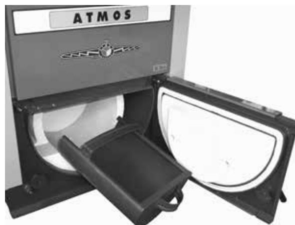
Otwarta dolna komora spalania z kształtkami kulistymi. Pokazany sposób usuwania popiołu specjalnie uformowaną szufelką
