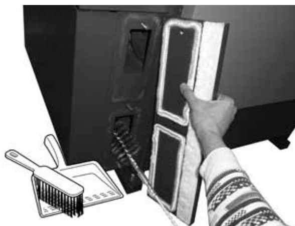
Usuwanie popiołu z dolnej części kanału spalinowego poprzez wieczko dolne (po obu stronach)
